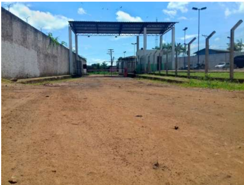
Figura 51 – Vias de acesso ao Porto de Santana – Portão G1 Fonte: Imagem fornecida pela CDSA (2018).
