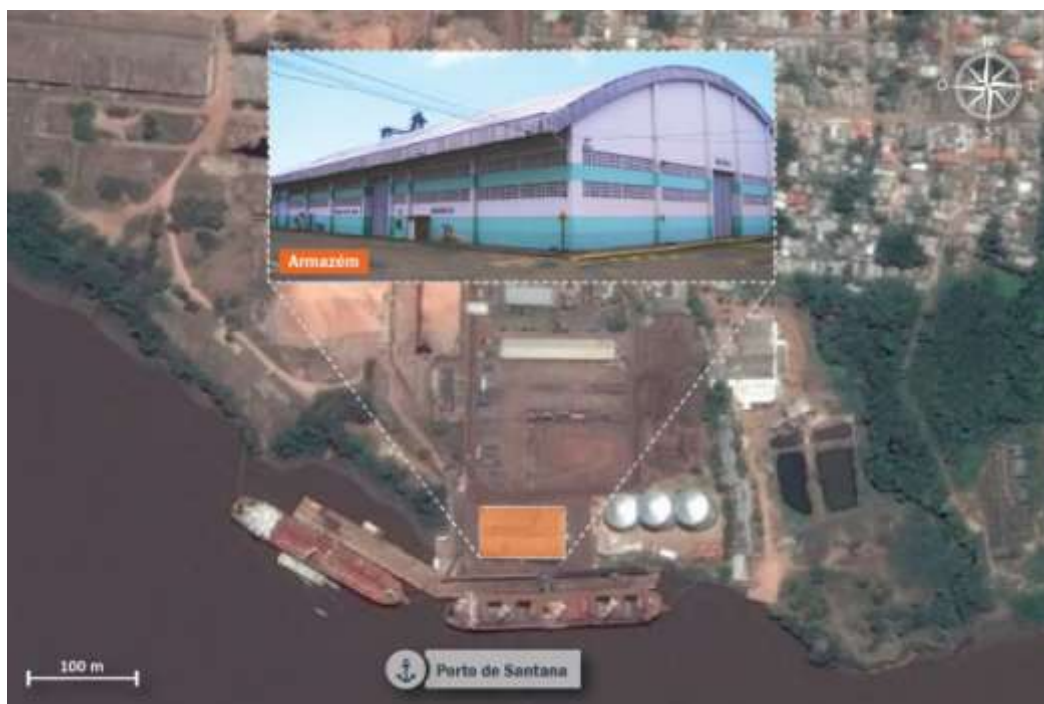
Figura 16 – Localização do armazém do Porto de Santana Fonte: Google Earth (2017). Elaboração: LabTrans/UFSC (2018)
