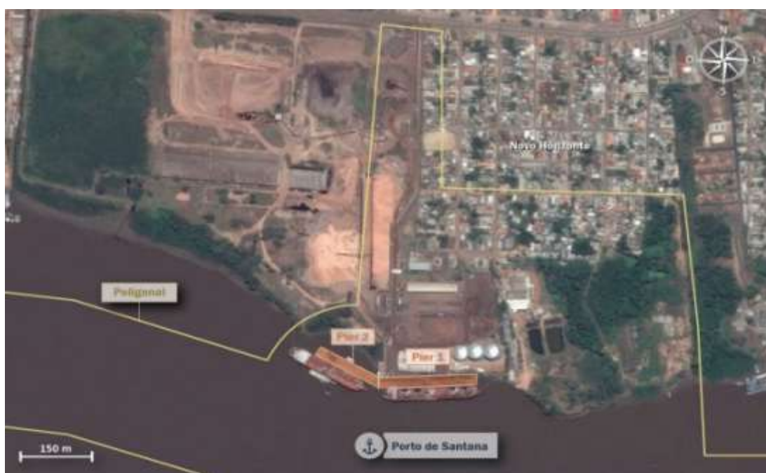
Figura 11 – Infraestrutura de acostagem do Porto de Santana
