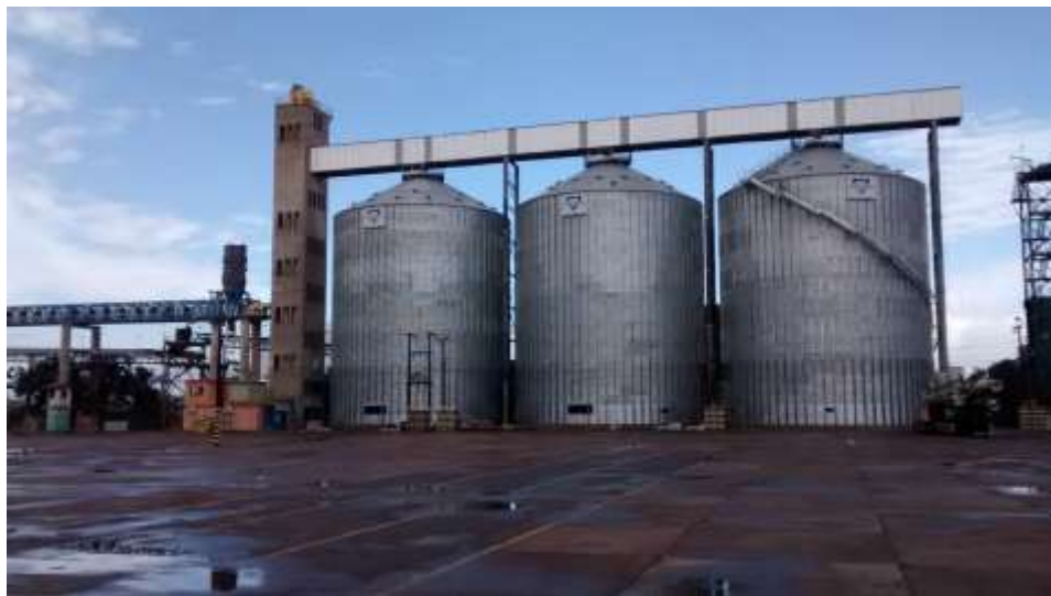
Figura 19 – Construção novos silos Fonte: Google Earth (2017). Elaboração: LabTrans/UFSC (2018)
