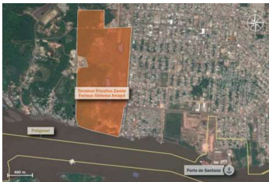
Figura 26 – Terminal da Zamin Amapá Mineração S.A. Fonte: Google Earth (2017). Elaboração: LabTrans/UFSC (2018)
