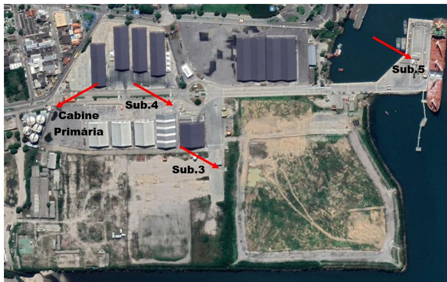
Figura 17. Localização da Cabine Primária e das Subestações
