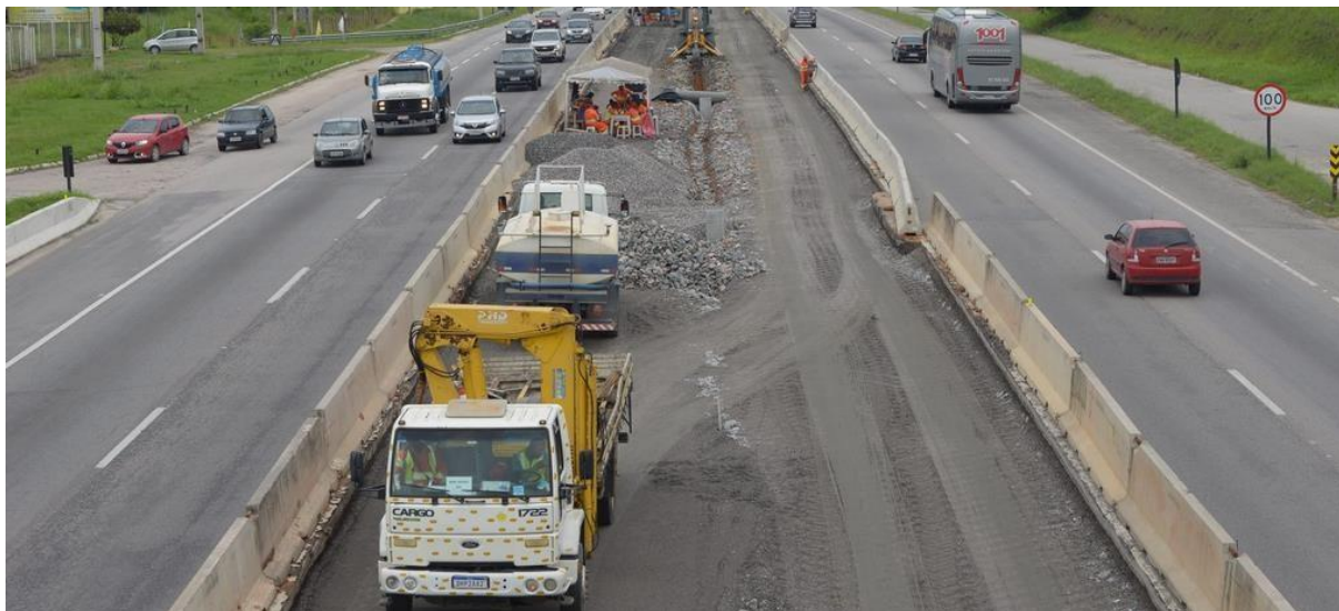
Figura 21 – Obras na rodovia BR-101/Norte.
