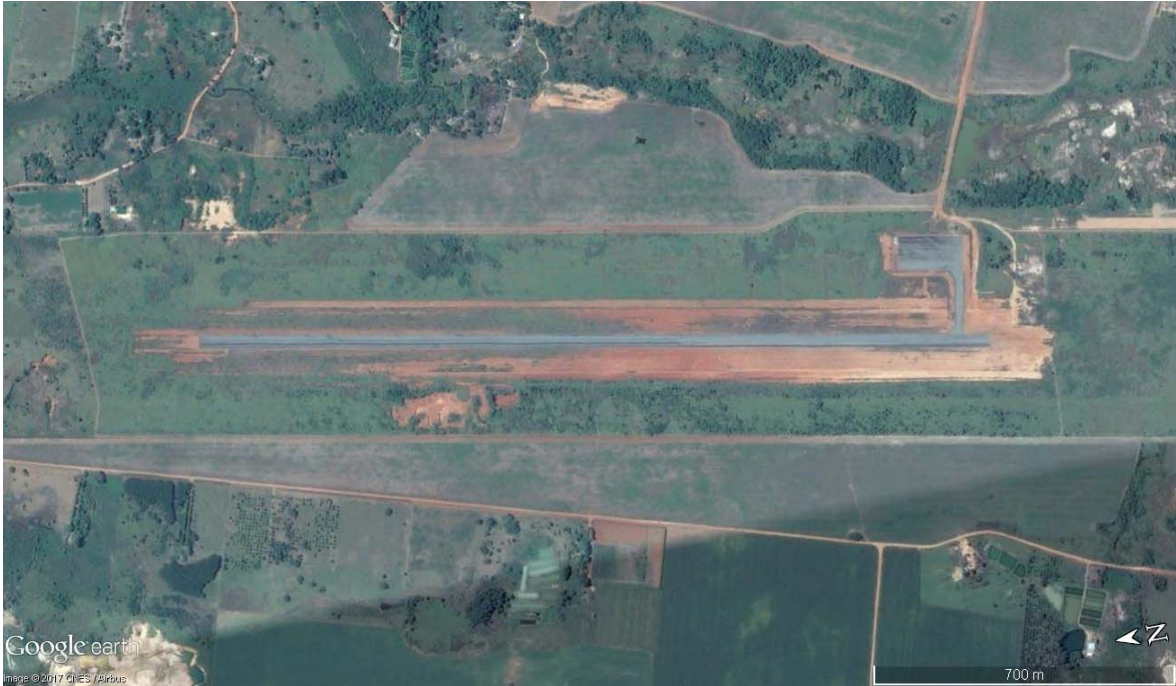
Figura 5 – Imagem via satélite do Aeroporto de Matupá Fonte: Google Earth (2017). Elaboração: LabTrans/UFSC (2018)
