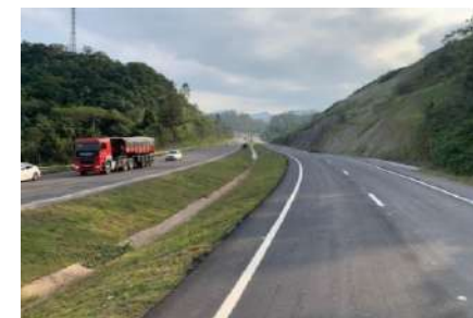
Adequação da BR-470/SC – Navegantes – Rio Sul (fonte: Mlnfra)
