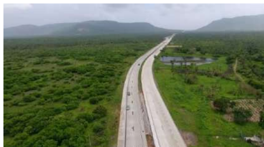
Duplicação do acesso rodoviário ao Porto de Pecém na BR-222/CE (fonte: Mlnfra)
