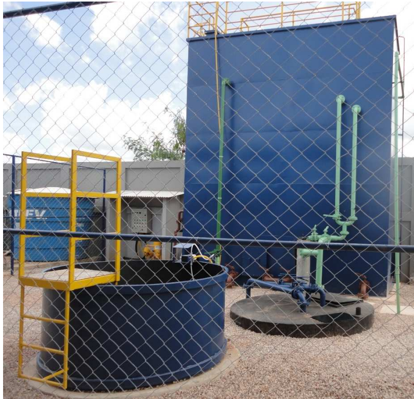
Figura 16. Dique de contenção do coagulante.
