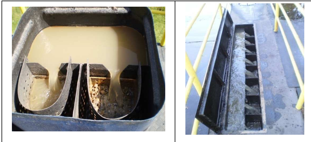
Figura 8. Cesto da caixa receptora de esgoto bruto e caixa de distribuição do esgoto modelo Sanevix.
