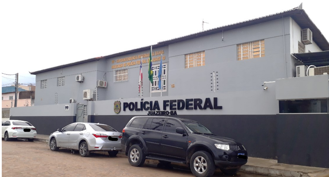
Fotografia 01 – Imagem da fachada da edificação nomeada “Principal”.
