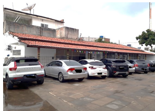
Fotografia 04 – Imagem da fachada da edificação nomeada “Academia e Copa/Cozinha”.
