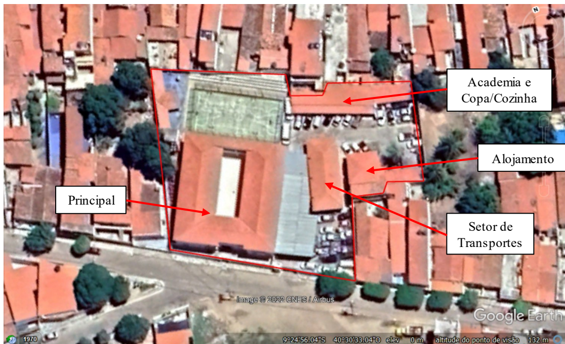
Figura 02 – Detalhe da imagem de satélite anterior, datada de 2021, da localização do imóvel vistoriado. A área do imóvel avaliando foi delimitada pelo polígono vermelho. E as edificações principais foram indicadas na imagem. Fonte: Google Earth Pro .
