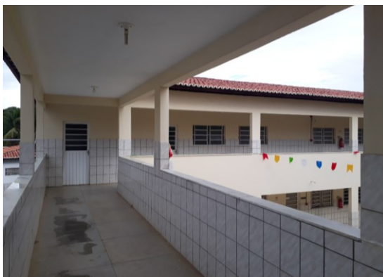
Fotografia 11 – Imagem do corredor do pavimento superior da edificação nomeada “Principal”.
