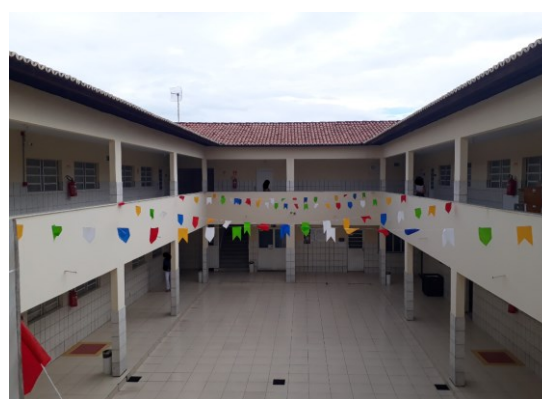
Fotografia 10 – Imagem da área central da edificação nomeada “Principal”.
