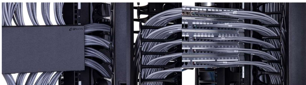
Figura 2 - Guias para cabos em Plástico.
