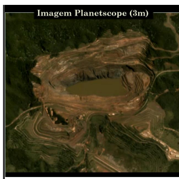
Fonte: Planet Inc. via contrato nº 32/2019.
