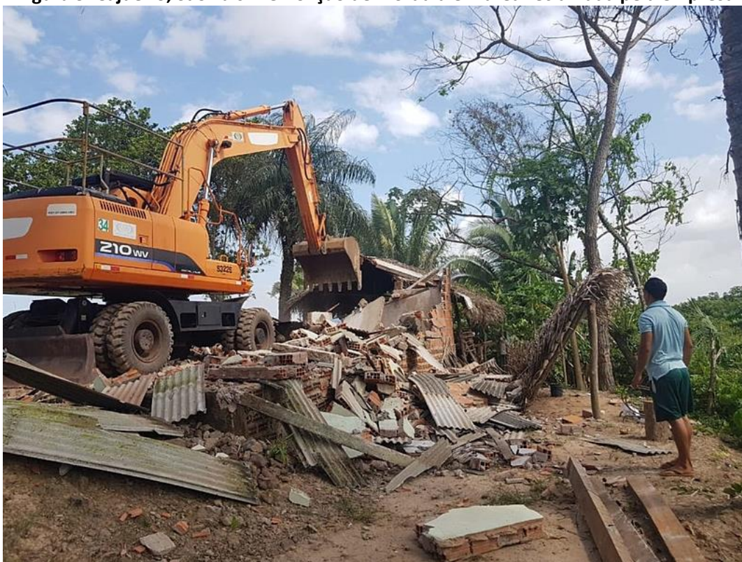
Figura 3: Cajueiro, São Luís: Demolição de moradia em área reclamada pela empresa
