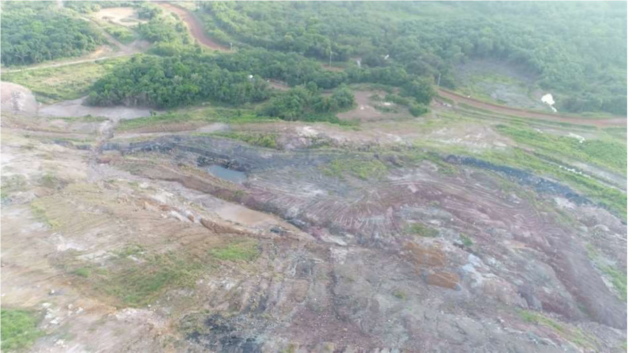
Foto 5: Vista aérea de área atingida pelo deslizamento de estéril
