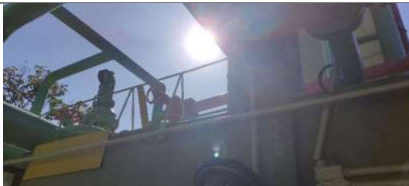
Figura 3 – C.M.I. sem cobertura
