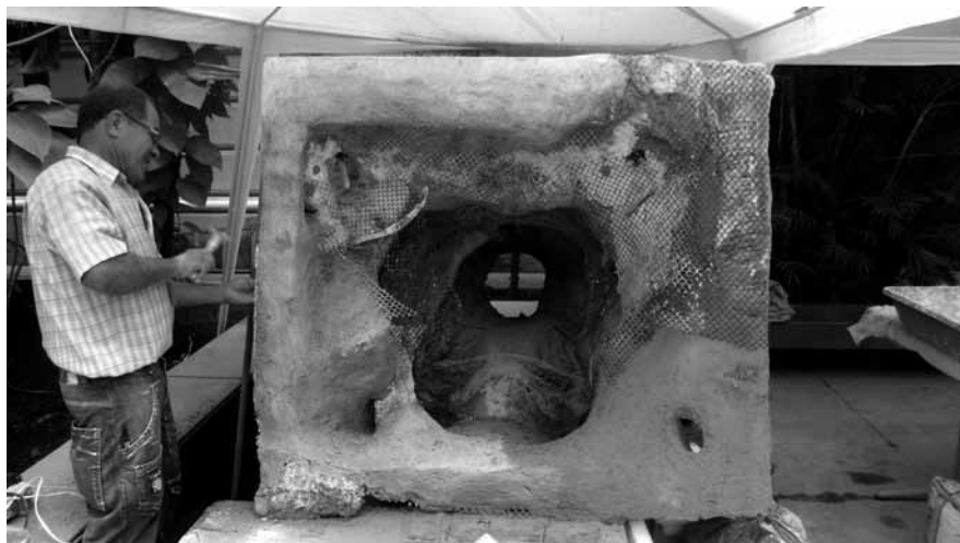
Reforço estrutural da escultura
