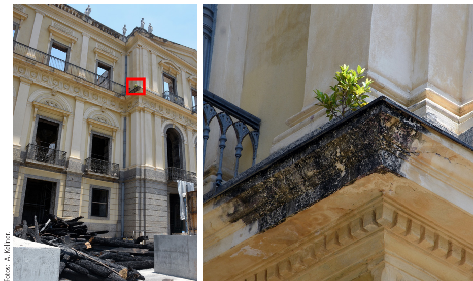
Figuras 2 e 3 - Fachada do Museu Nacional, com restos de madeira queimada entre duas sapatas de concreto, base de uma cobertura que está sendo instalada. Na caixa vermelha, uma planta. Detalhe da fachada destacada na foto 3, mostrando um planta que está crescendo no local
