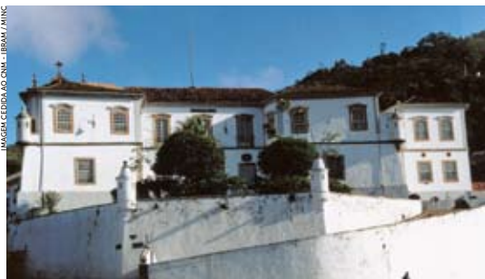
Museu de Ciência e Técnica da Escola de Minas da Universidade Federal de Ouro Preto - Ouro Preto
