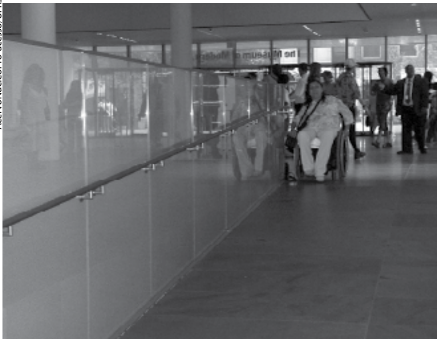
Moma: rampa de acesso para pessoas em cadeira de rodas no interior do Moma
