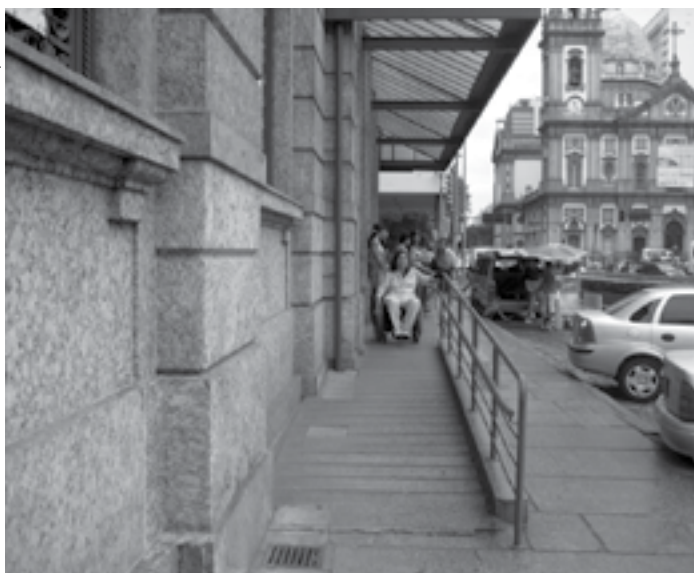
Centro Cultural Banco do Brasil, Rio de Janeiro: rampa de acesso com corrimão e piso antiderrapante
