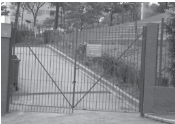
Figura 2.7 – Portão com visão para o interior
