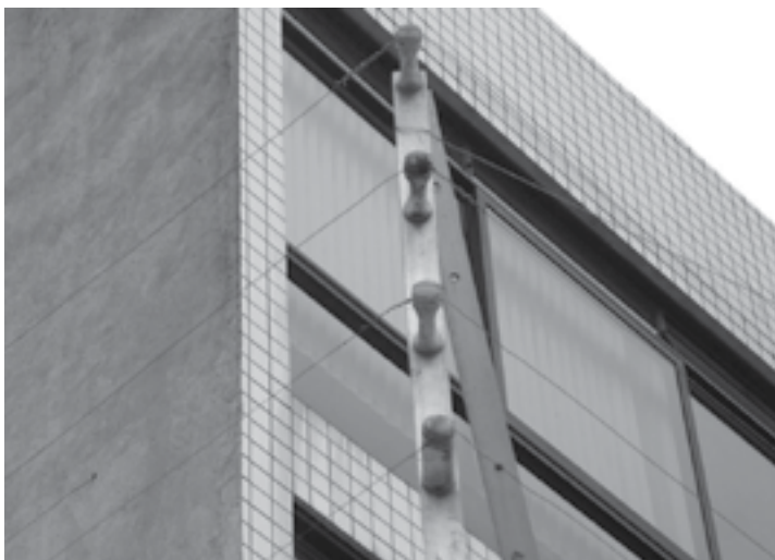
Figura 2.22 – Cerca Elétrica
