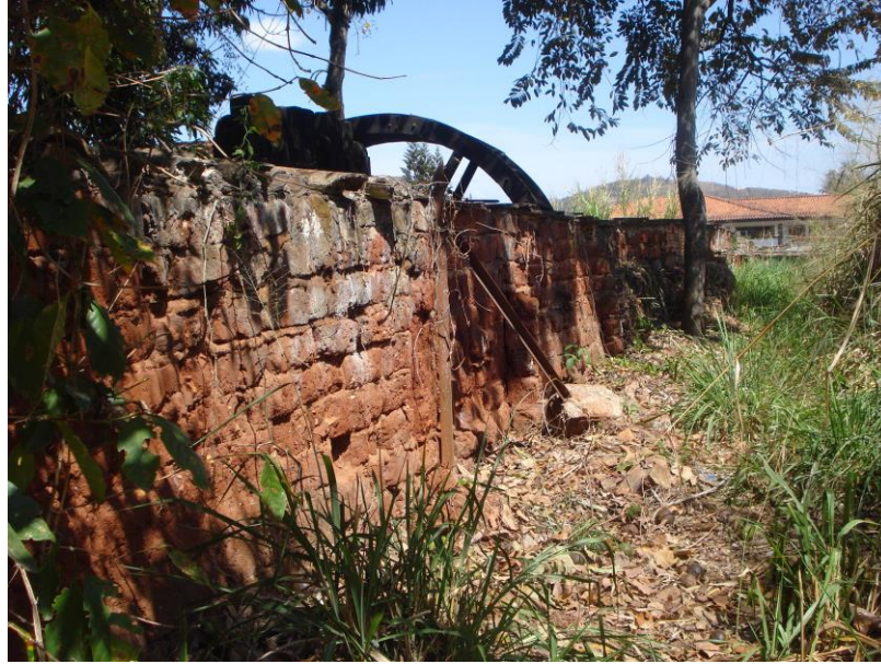
Vista geral do Muro pelo terreno vizinho
