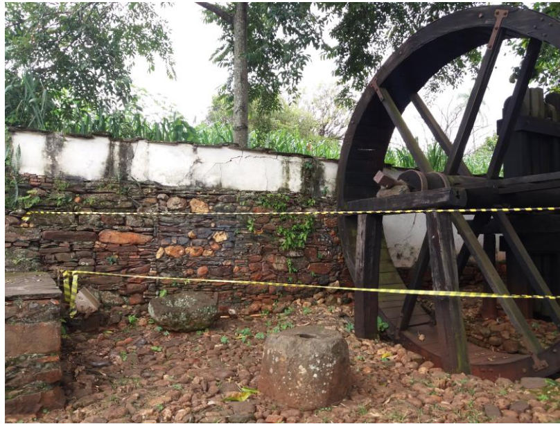
Vista geral do Muro pelo terreno do Museu
