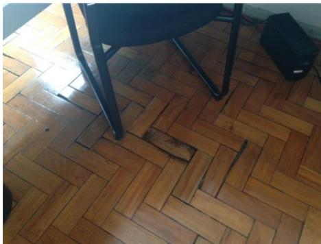
Figura 05 – Piso de tacos com unidades “soltas” que necessitam ser fixadas.
