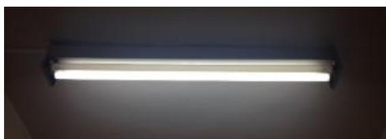
Figura 09 – Luminárias com necessidade de troca de reatores.
