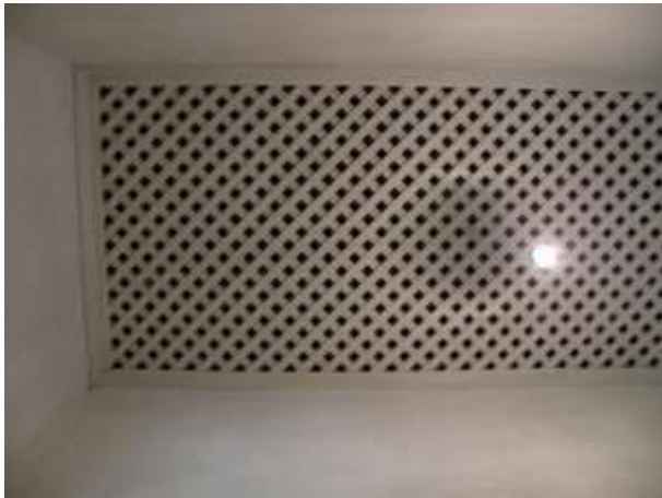
Detalhe do forro.
