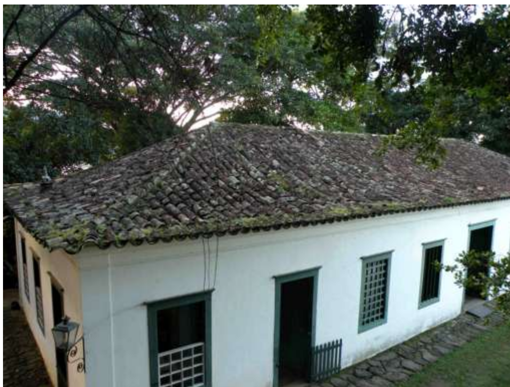
Vista superior do telhado do Forte Defensor Perpétuo
