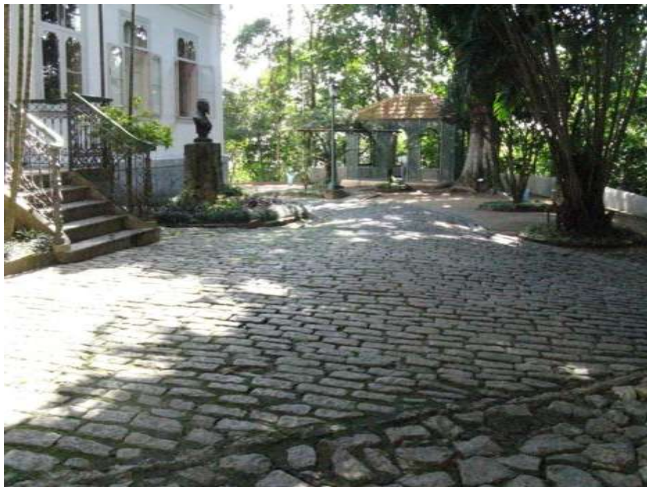
Pavimentação do entorno da Casa Histórica e de acesso ao museu.
