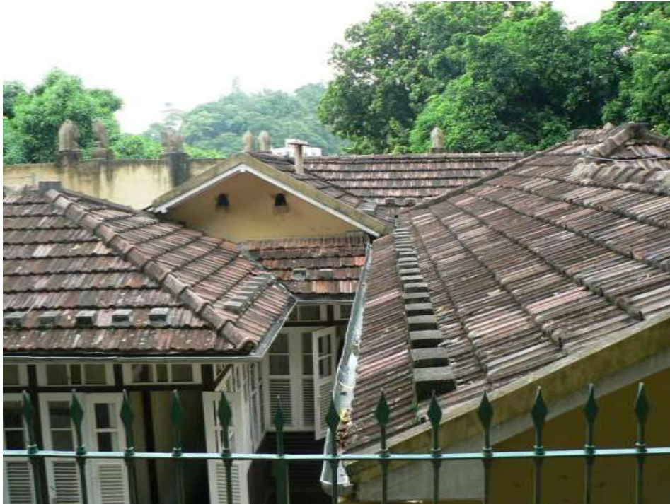
Telhado da Casa de Bernardina.
