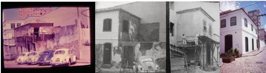
Figs. 07, 08, 09 e 10 - Obra de restauração do Museu Casa Victor Meirelles (1969/1970)
