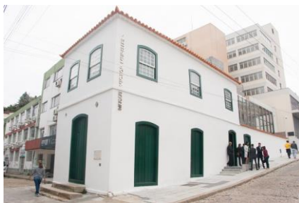
Fig. 08 – MVM depois da Obra de Restauração e Ampliação (2019)
