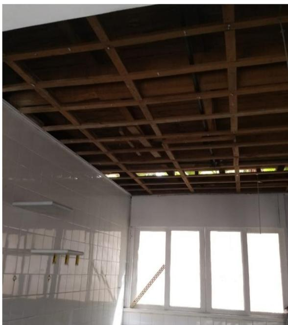
Foto 1: Troca dos telhados das áreas técnicas
