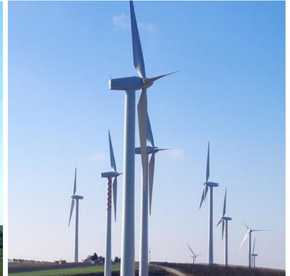
Parque Eólico | Fumosa (Tp, Itália)
