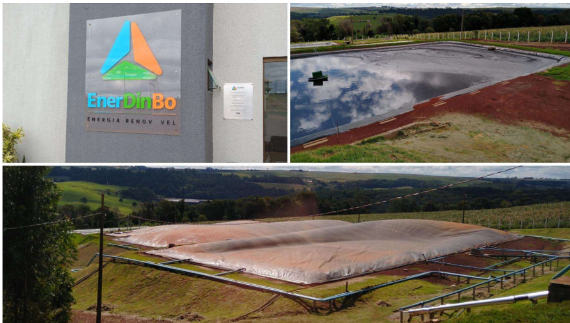
Figura 7 – Usina EnerDinBo (2 MW) – Ouro Verde do Oeste (PR)
