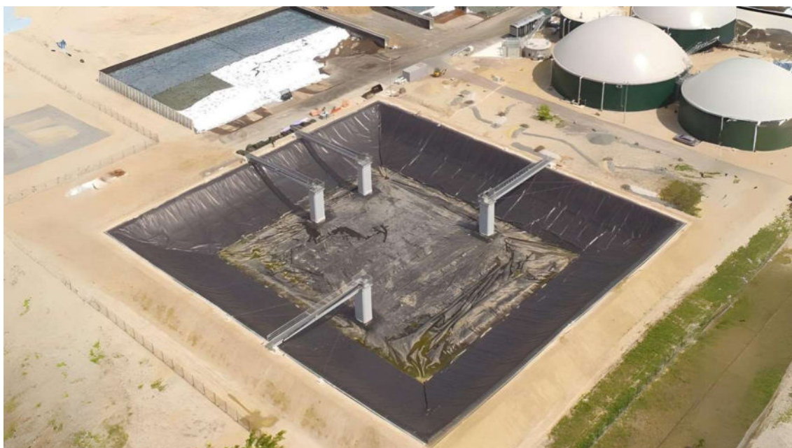
Figura 20 – Tanque para tratamento e armazenamento do digestato
