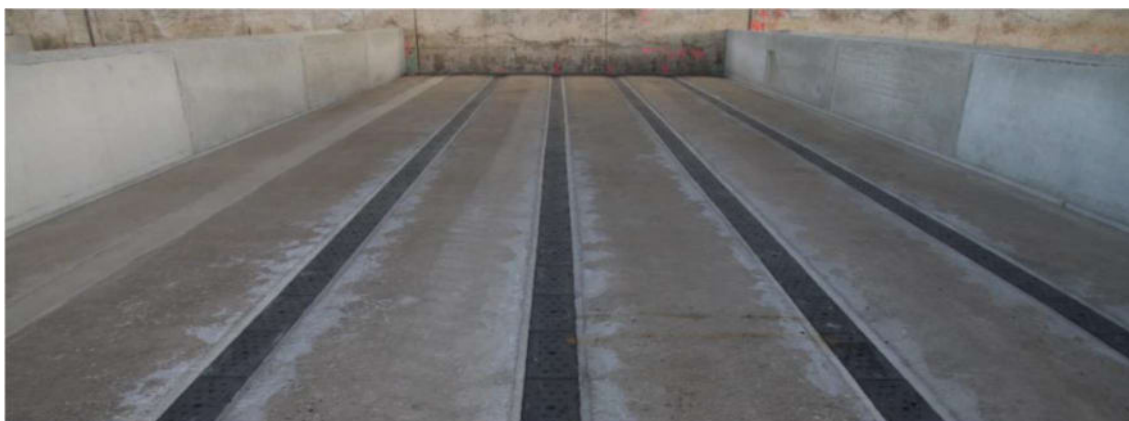
Figura 34 – Sistemas de secagem do lodo em processo de compostagem
