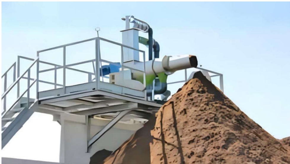
Figura 29 – Processo de separação mecânica – separação de sólidos em filtro prensa
