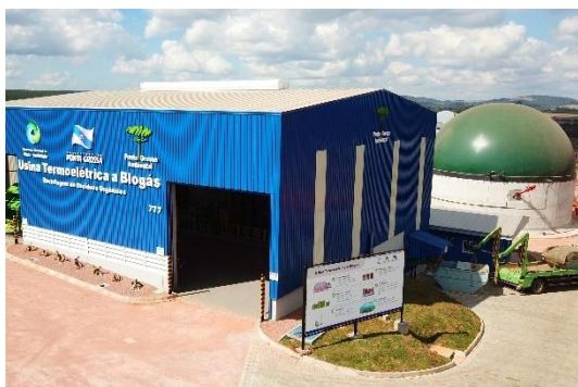
Figura 10 – Usina Termelétrica a Biogás (UTB)
