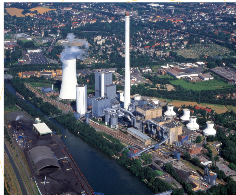
Usina de Herne, na Alemanha.
