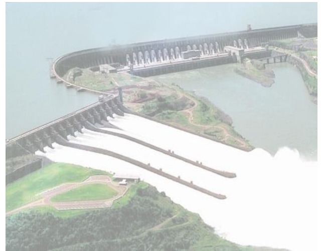
Usina Hidrelétrica de Itaipu (Itaipu Binacional/Divulgação)
