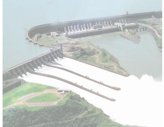
Usina Hidrelétrica de Itaipu (Itaipu Binacional/Divulgação)
