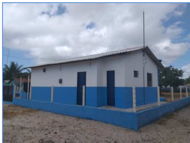
Figura 4 – Abrigo para os equipamentos (Fonte: Acervo Eletrobras)
