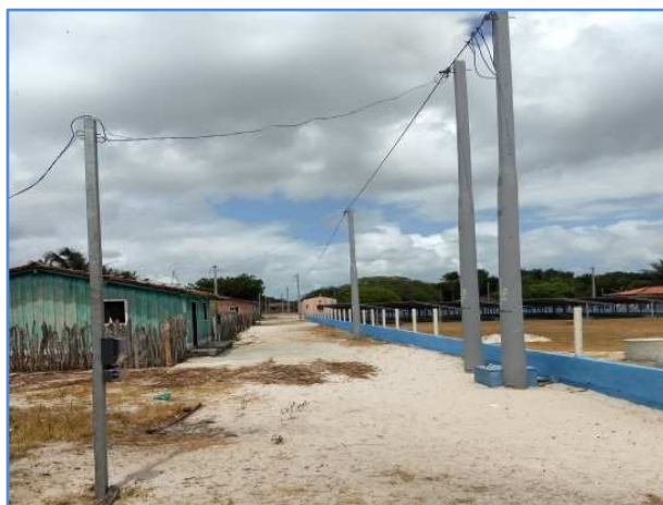
Figura 5 - Minirrede de distribuição (Fonte: Acervo Eletrobras)
