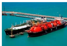
Terminal de GNL
