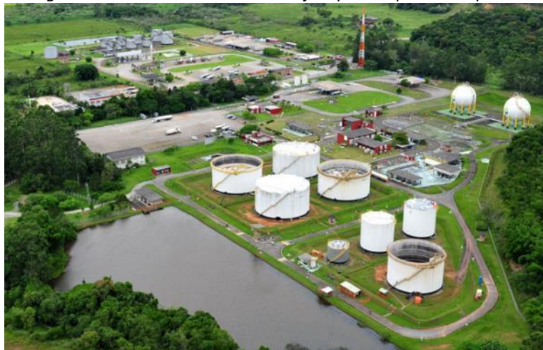
Figura 26 – Vista do terminal de Itajaí operado pela Transpetro
