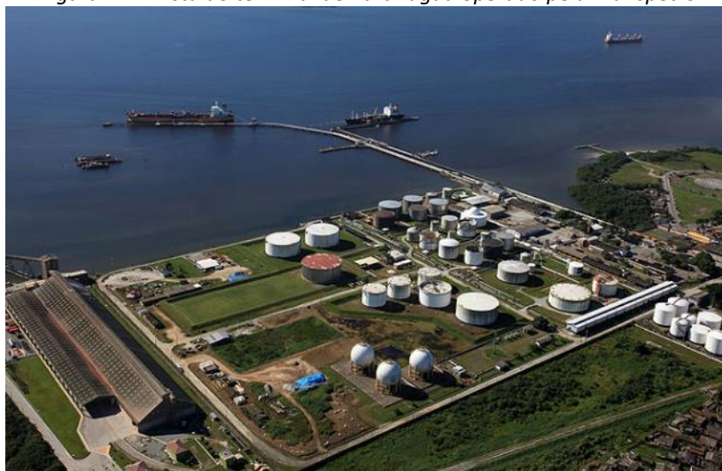
Figura 24 – Vista do terminal de Paranaguá operado pela Transpetro
