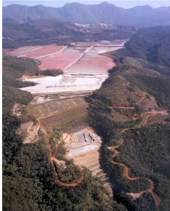
Vista Aérea da Pilha a Jusante da Barragem do Germano para estabilidade no fechamento em estágio inicial de Construção
