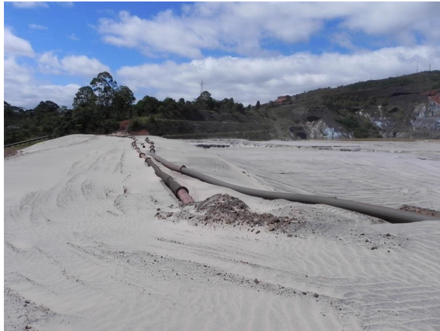
Vista de Jusante da Pilha da Cava do Germano
