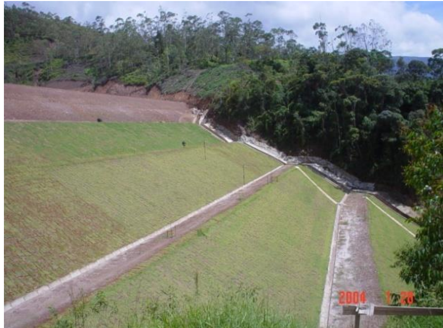
Vista do Talude Final com o Fechamento Progressivo sendo
