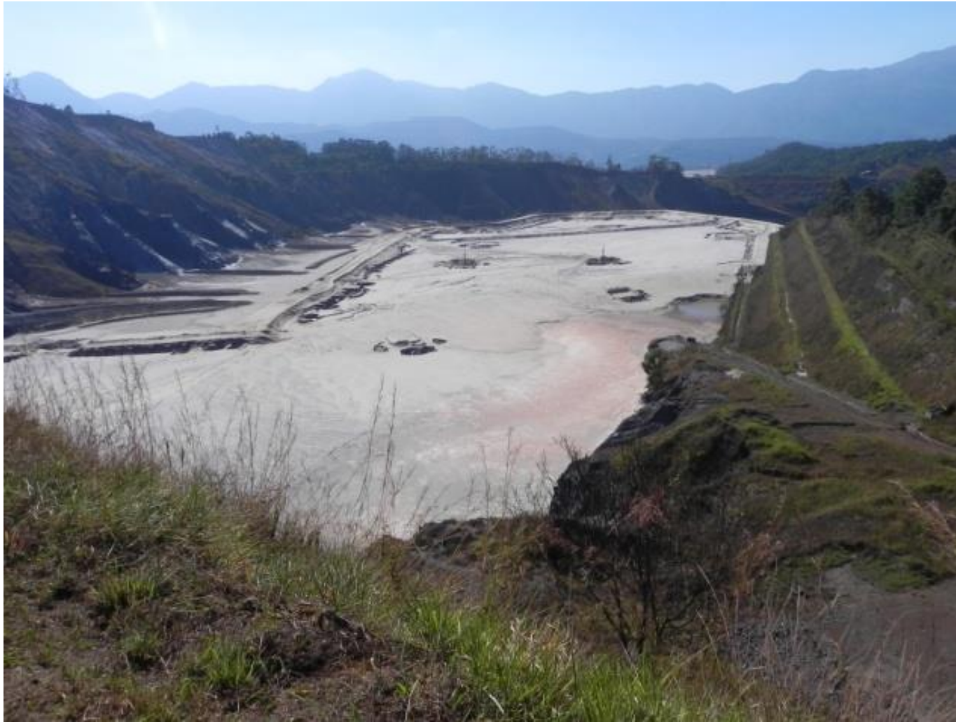
Fechamento da cava do germano com empilhamento
