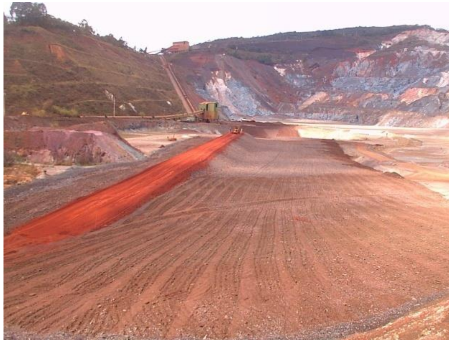
Vista da Cava do Germano, Com o Tapete Drenante Sendo Construído
