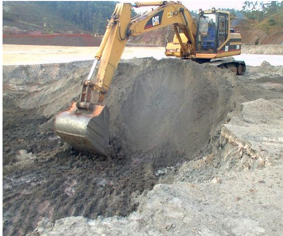
Vista da Superfície dos Rejeitos Sendo Escavados Para Obtenção de Material Para Construção do Dique de Alçamento
