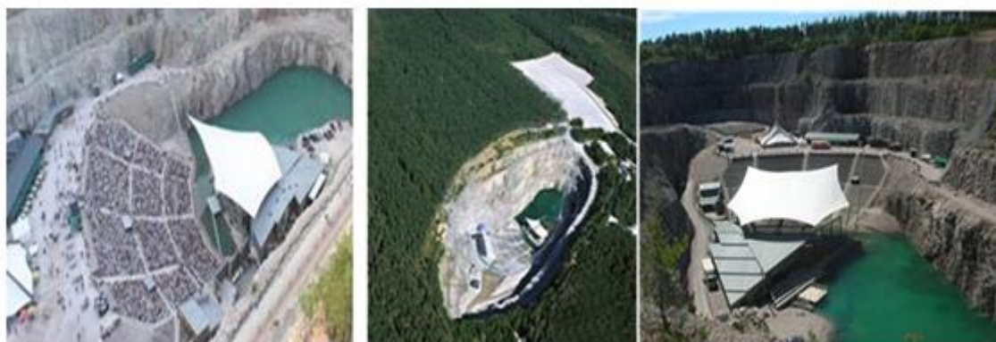
Figura 17 - Ópera de Dalhalla (Suécia), pedreira de Calcário por 51 anos (1940 a 1991), onde se observa a não revegetação dos taludes da cava da mina para favorecer a acústica local. Fonte: https://www.dalhalla.se/en/om-dalhalla/
