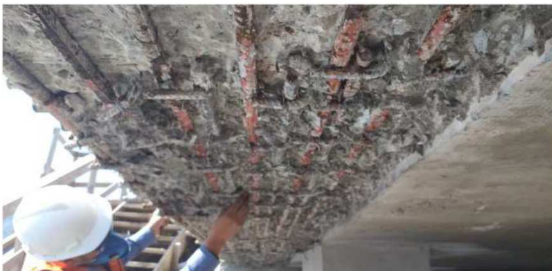
Imagem 2: abertura da face inferior da plataforma recuperada em 2008
