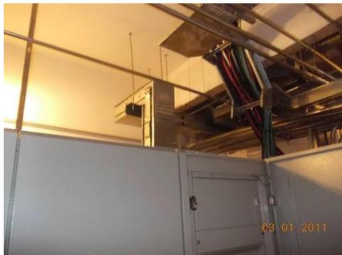
**Figura 1.31** – saída do barramento blindado do painel de baixa tensão localizado próximo à subestação
