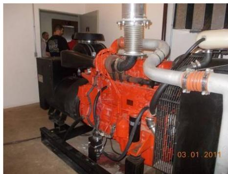
**Figura 1.34** – grupo motor gerador utilizado para suprir cargas essenciais
