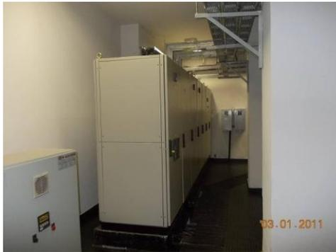
**Figura 1.10** – painéis de baixa tensão, barramento blindado, banco de capacitores e o medidor, instalados próximos a subestação
