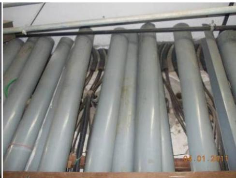
**Figura 1.17** – cabos de cobre utilizados na interligação entre os painéis de baixa tensão e os quadros de distribuição
