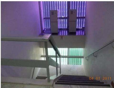
**Figura 1.16** – estabilizadores utilizados pelos equipamentos de informática
