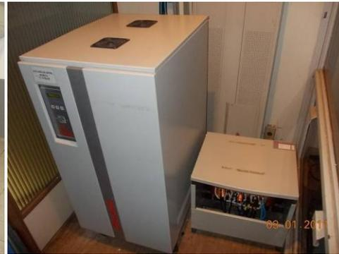
**Figura 1.9** – estabilizador utilizado pelos equipamentos de informática
