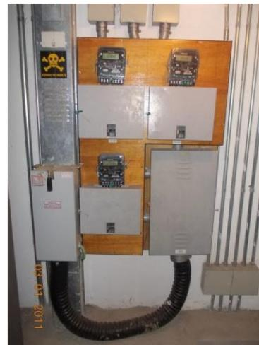
**Figura 1.32** – conexão do barramento blindado aos medidores de energia elétrica
