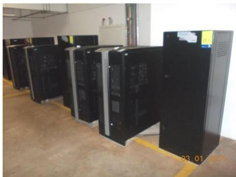
**Figura 1.33** – *no-break* utilizado pelos equipamentos de informática
