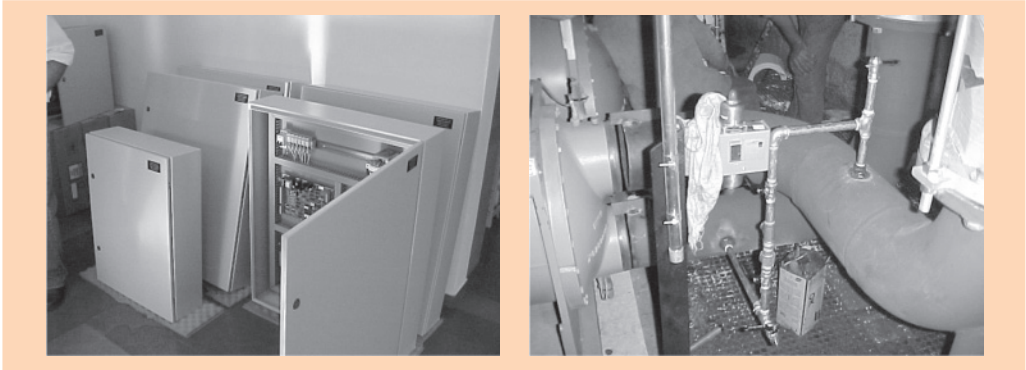
Figura 4.13b - Etapas de substituição dos equipamentos
