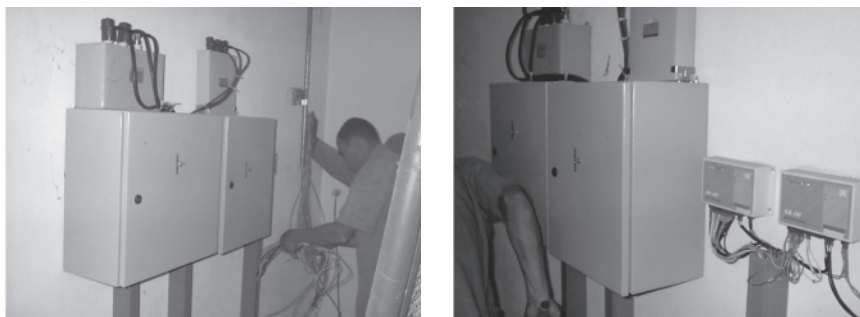
Figura 1.7 - Instalação do banco de capacitores e módulo do gerenciador
