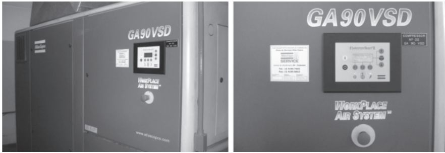
Figura 5.11 - Compressor com controle de vazão por variação da rotação
