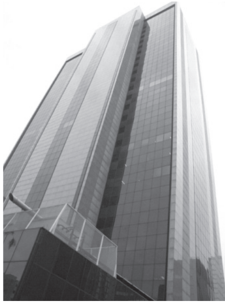
Figura 4.10 - Vista frontal do edifício
