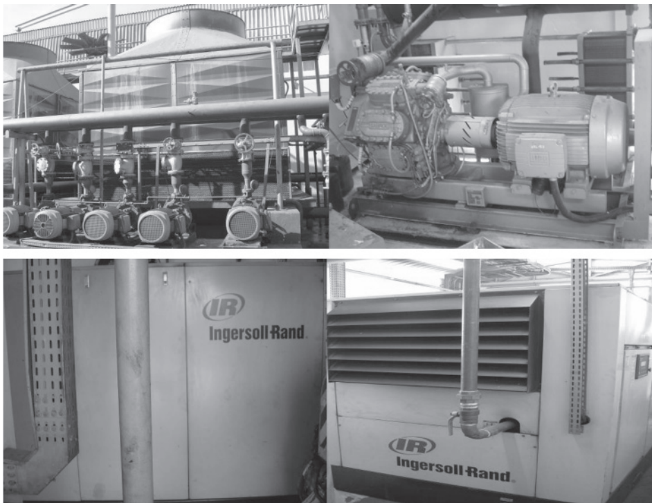
Figura 1.26 - Gerenciamento de água gelada e substituição de compressor
