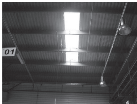
Figura 2.8 - Telha translúcida na Oficina de Goma
