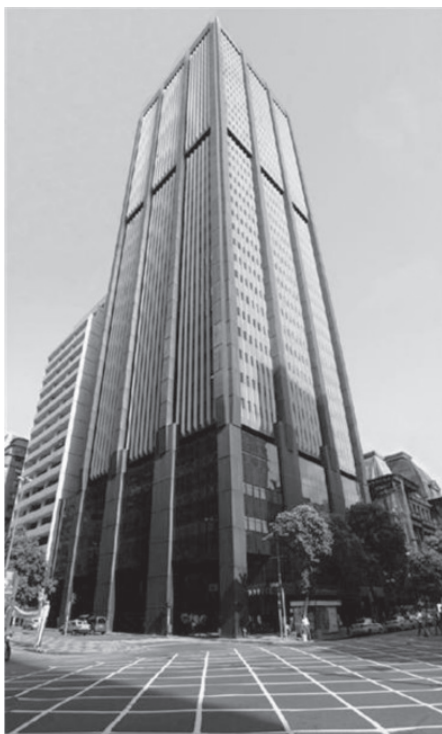
Figura 1.10 - Fachadas laterais do Edifício
