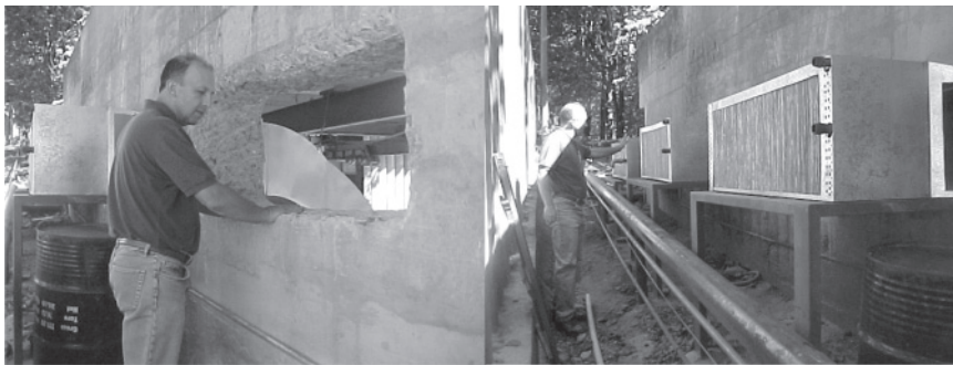
Figura 5.20 - Instalação dos trocadores de calor
