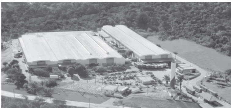
Figura 1.22 - Vista geral da planta industrial de Manaus
