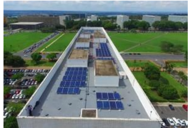
Painéis FV no edifício-sede do Ministério de Minas e Energia (MME)
