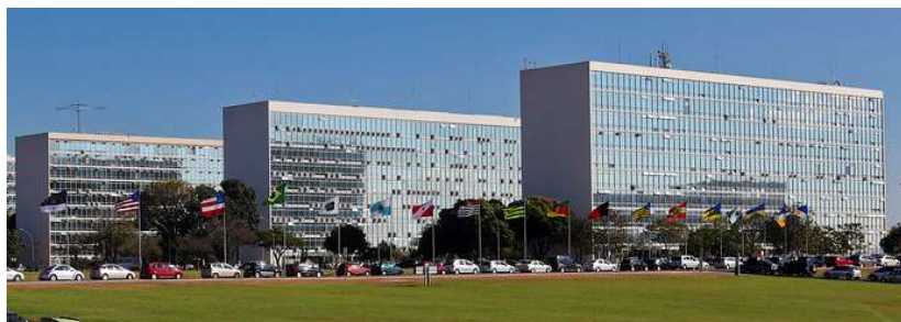
Figura 5- Fachada Leste- Esplanada dos Ministérios
