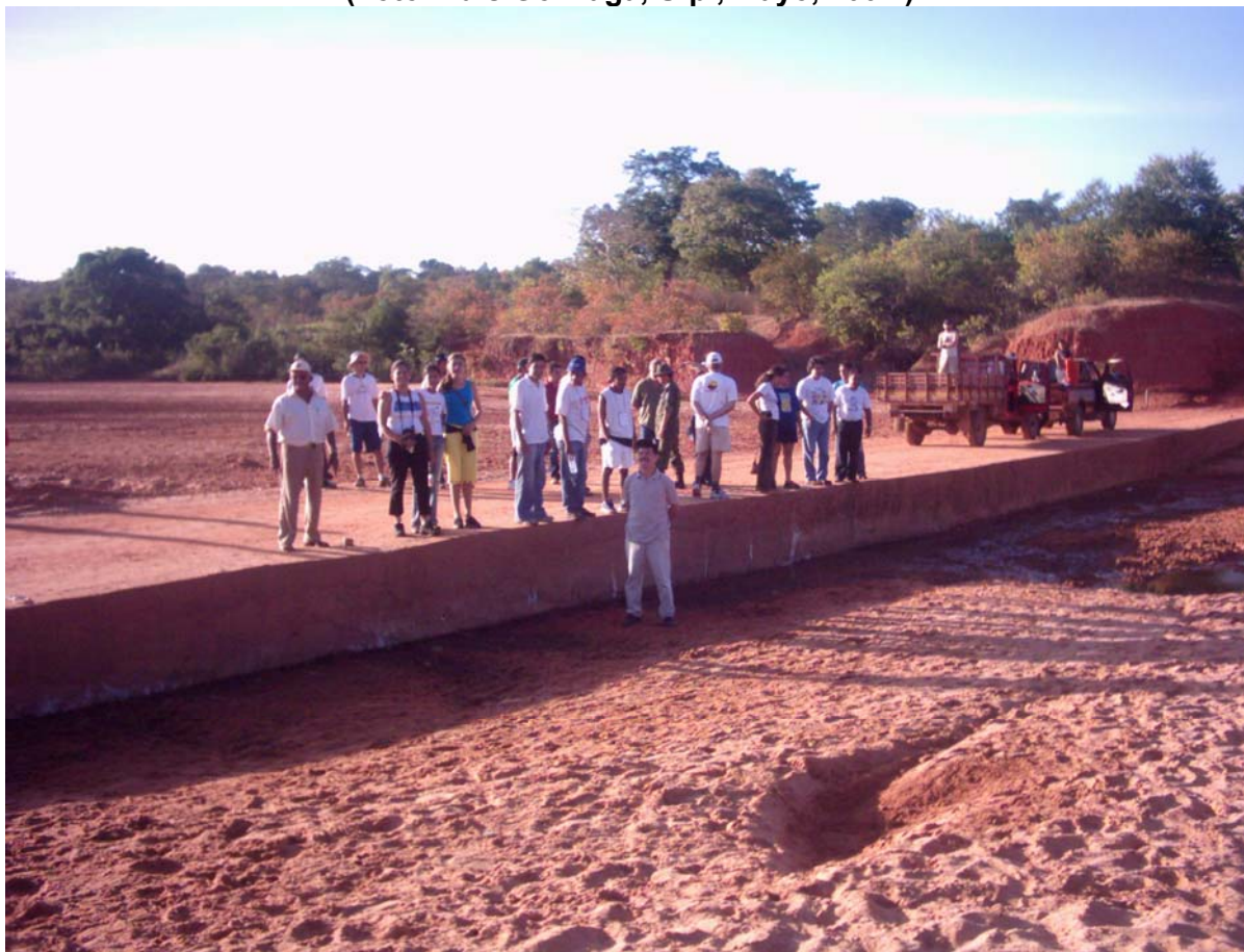
FIGURA 1.8 Puente del Boqueirão (80,0 M X 3,0 M X 3.724 Metros), sobre el Río del mismo nombre, en el Municipio de Gilbués, Piauí. (Foto: Luís Gonzaga, Ufpi, Mayo, 2004.)
