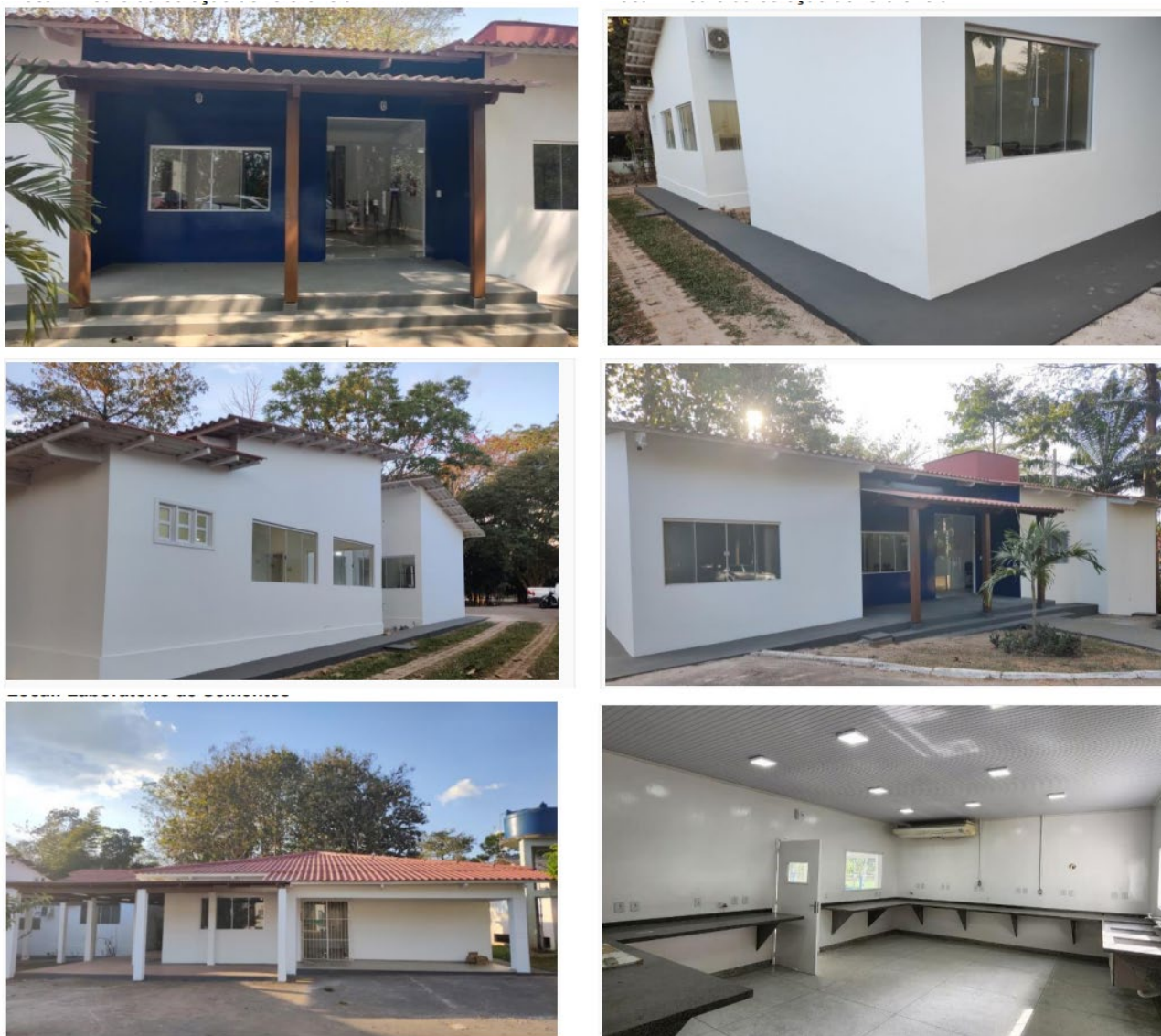
Figura 11– Finalização da reforma dos laboratórios de tecnologia de produtos naturais e de tecnologia de sementes florestais.
