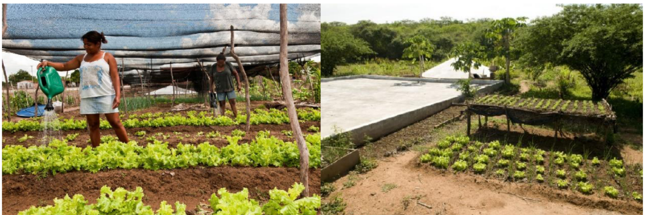
Figura 2: Cisternas calçadão de 52 mil litros
