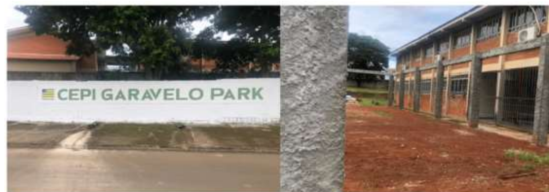
Figura 31 – Foto da fachada e de parte das obras - CEPI GARAVELO PARK - Aparecida de Goiânia/GO
