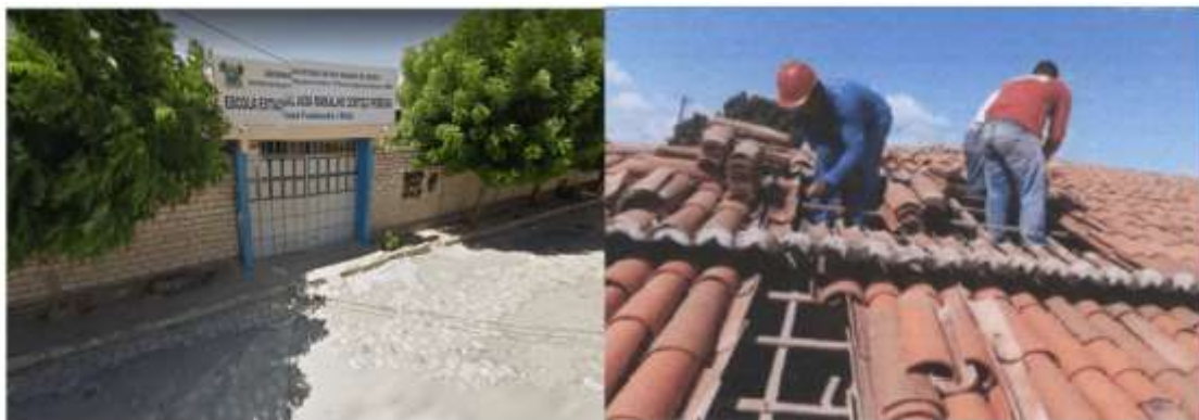
Figura 32 – Foto da fachada e de parte das obras - ESCOLA ESTADUAL AINDA RAMALHO DE CORTEZ PEREIRA - Mossoró/RN
