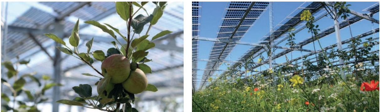
Figura 5 - Sistema agrivoltaico na fazenda de frutas orgânicas de Nachtwey, Alemanha
