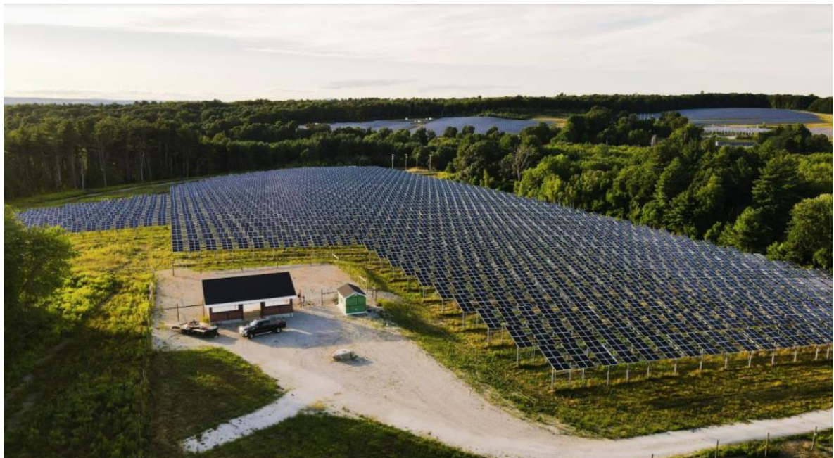
Figura 18 - Parte sul da usina agrivoltaica do projeto Grafton Solar
