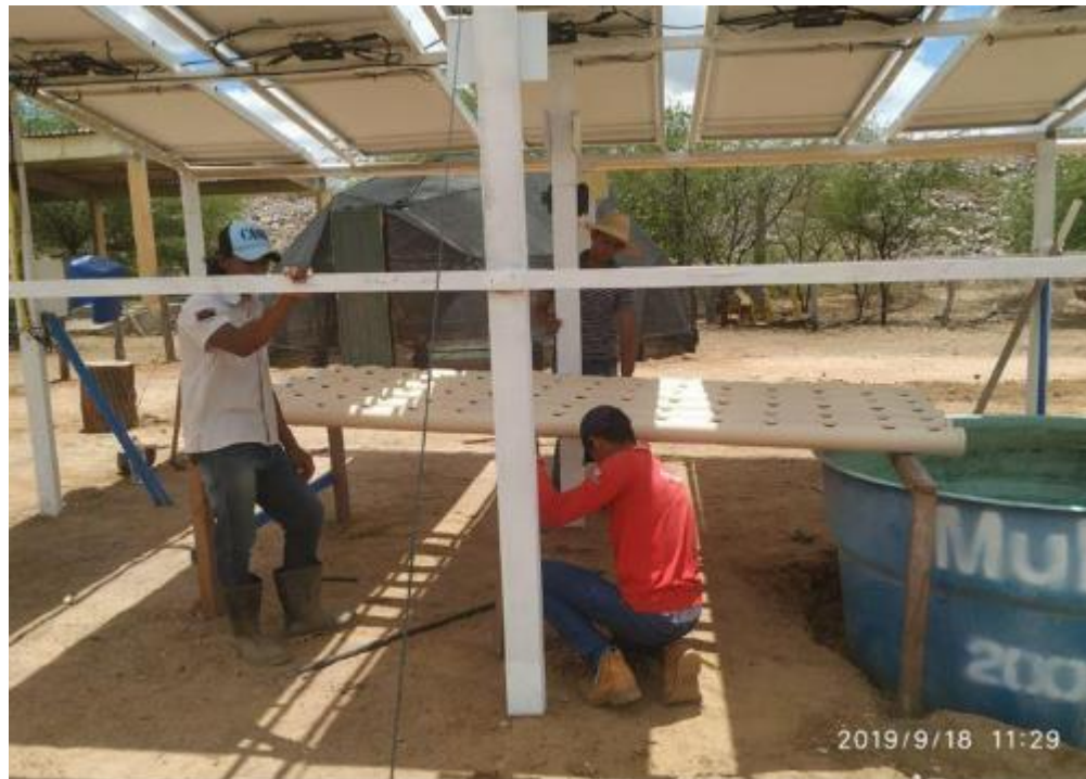
Figura 11 - Sistema agrivoltaico e montagem de sistema de aquaponia abaixo dos módulos (LACERDA et al., 2022)
