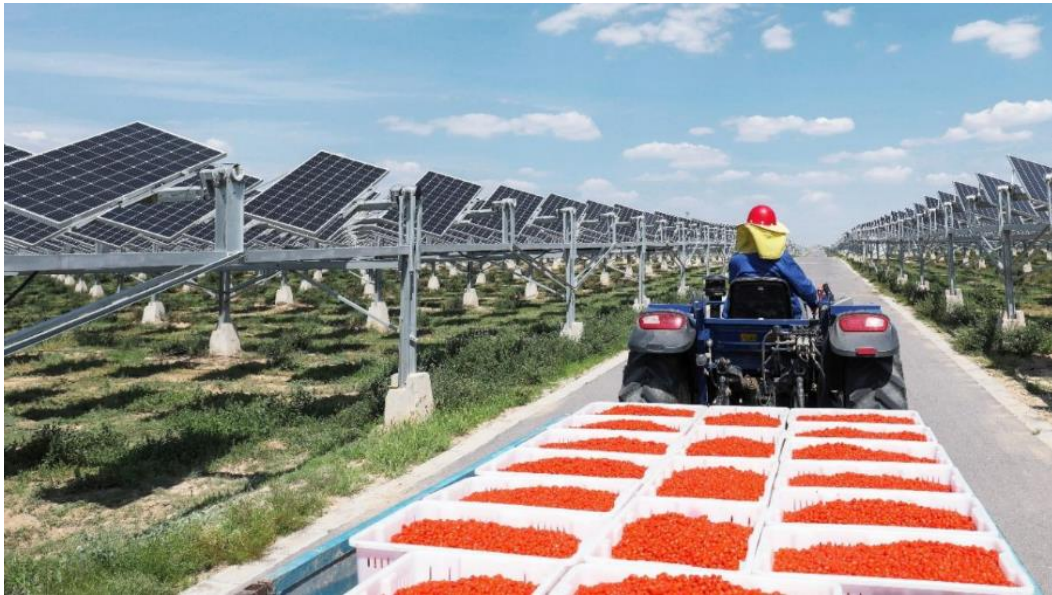
Figura 19 - Sistema agrivoltaico de grande porte com plantação de goji berry na China - que será expandido para 1 GW
