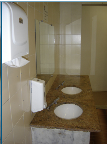
Foto 06 - Bancada e porta de acesso
