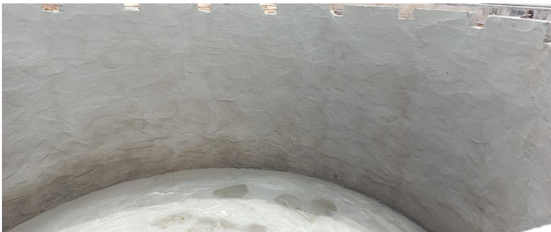
Figura 8: Acabamento interno do reboco lateral
