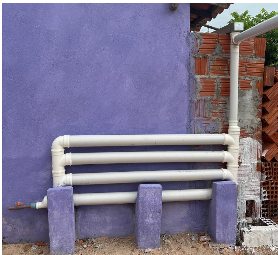
Figura 9: Modelo do dispositivo DesviUFPE para proteção da qualidade da água
