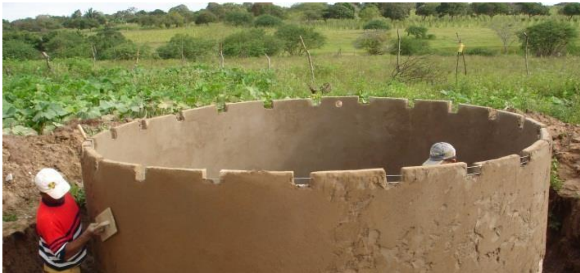
Figura 4: Reboco da cisterna
