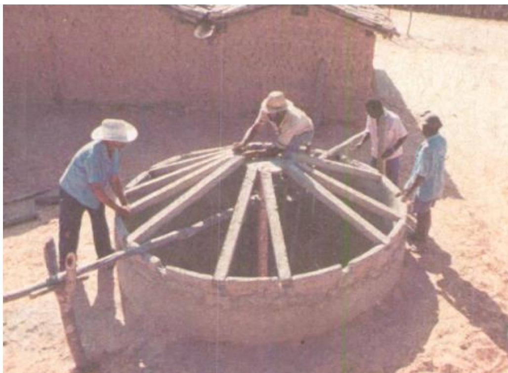
Figura 5: Fixação do pilar central e posicionamento dos caibros
