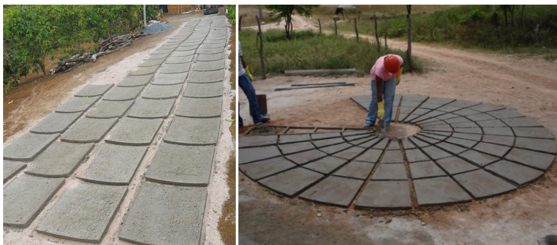
Figura 1: Confeção das placas de concreto
