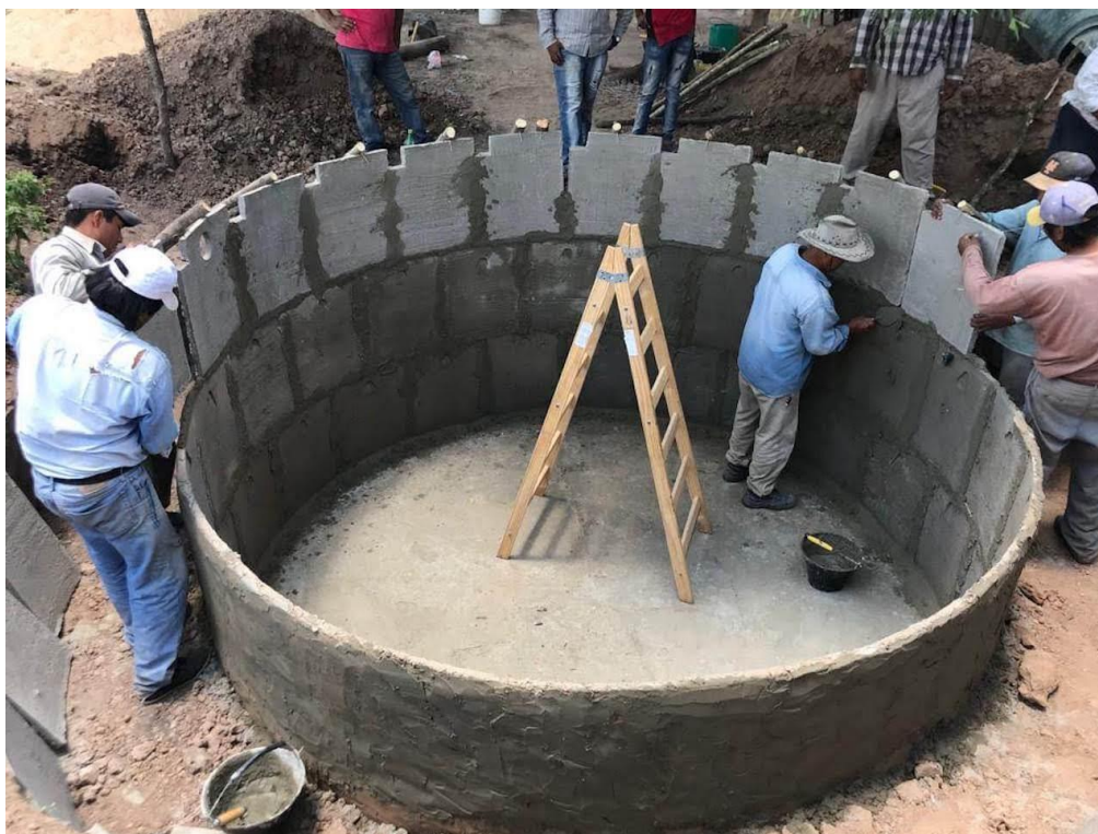
Figura 3: Confeção da primeira fileira de placas cimentícias
