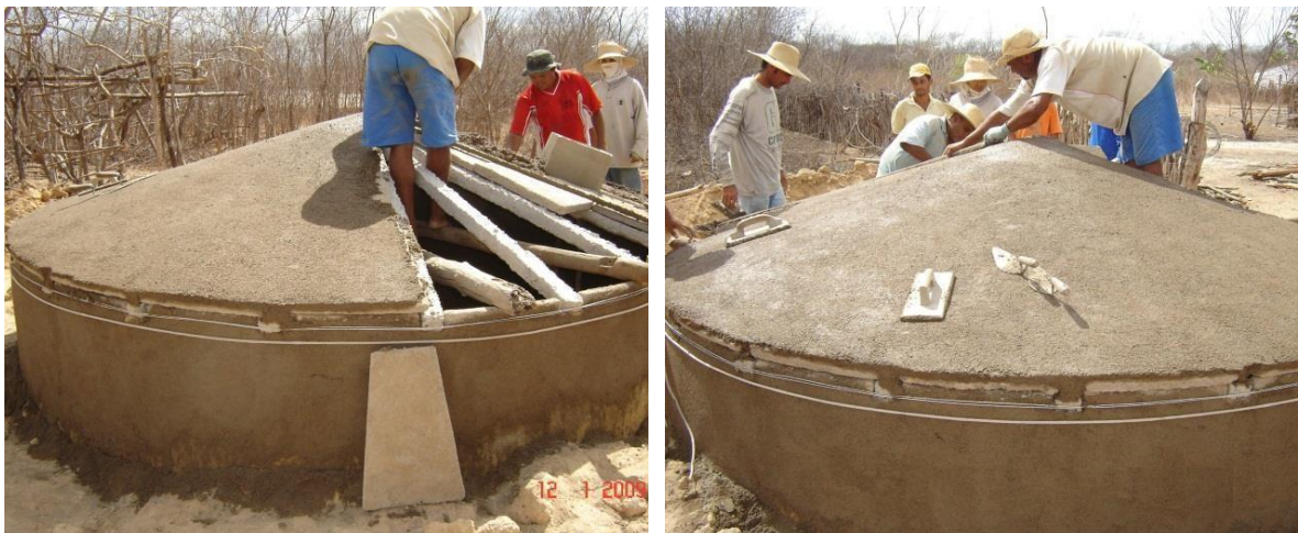
Figura 6: Instalação das placas e reboco do teto da cisterna
