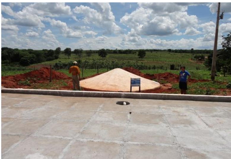
Figura 12: Calçadão concluído, mostrando as placas do piso devidamente rejuntadas
