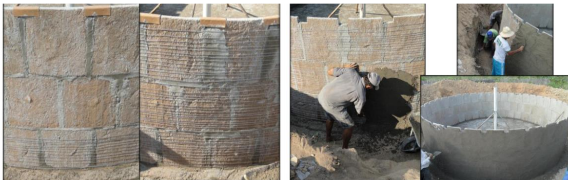
Figura 8: Amarração, reboco externo e interno
