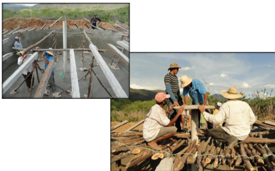
Figura 9: Colocação da coroa e dos caibros
