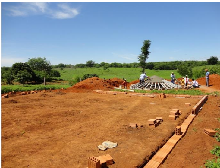
Figura 10: Construção do calçadão
