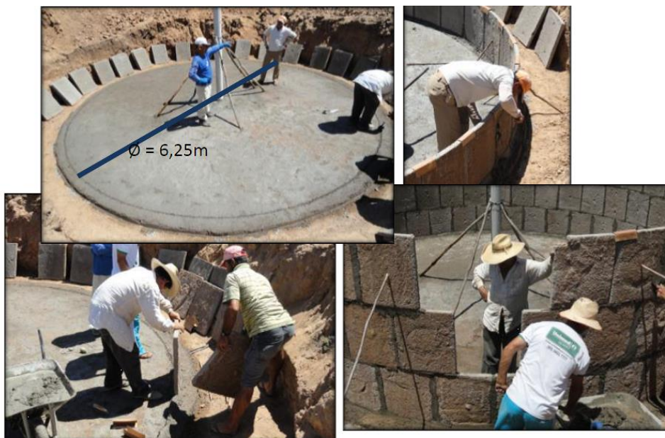
Figura 6: Construção da parede da cisterna
