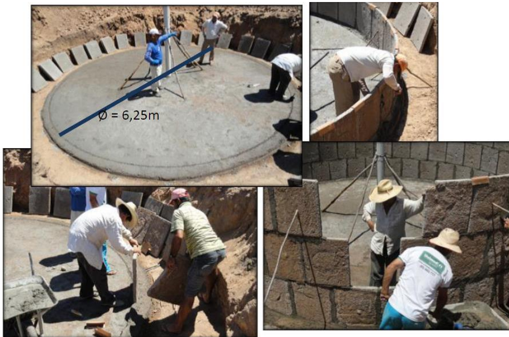
Figura 9: Construção da Parede da Cisterna
