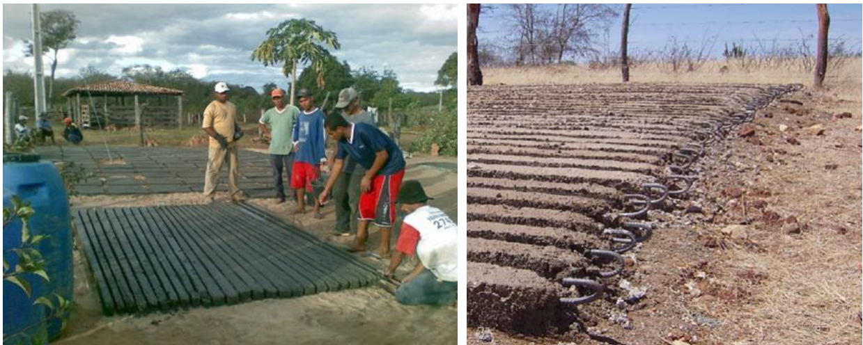
Figura 7: Confeção dos caibros da cobertura da cisterna
