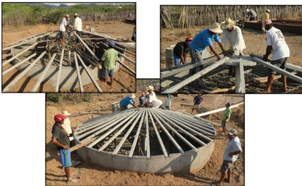
Figura 15: Colocação dos caibros
