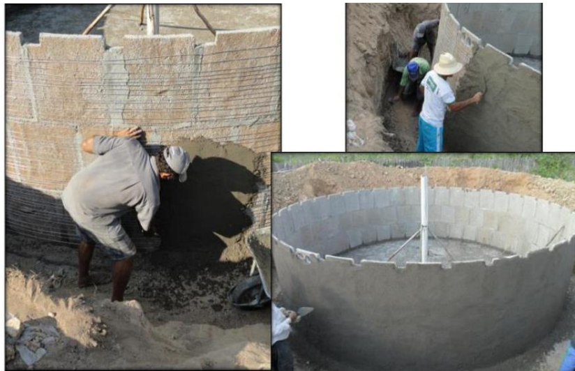
Figura 13: Reboco externo da cisterna
