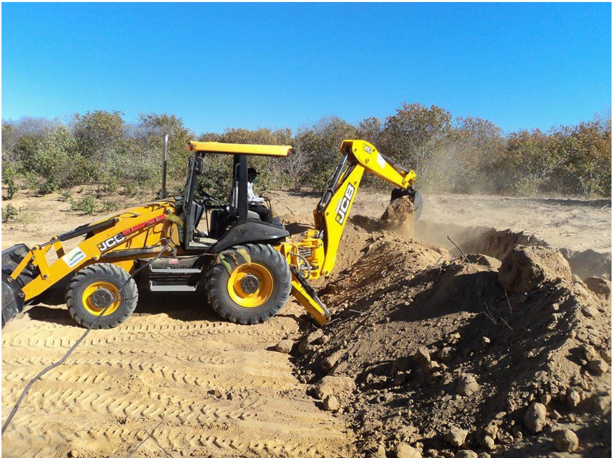
Figura 2: Escavação do buraco da cisterna com retroescavadeira
