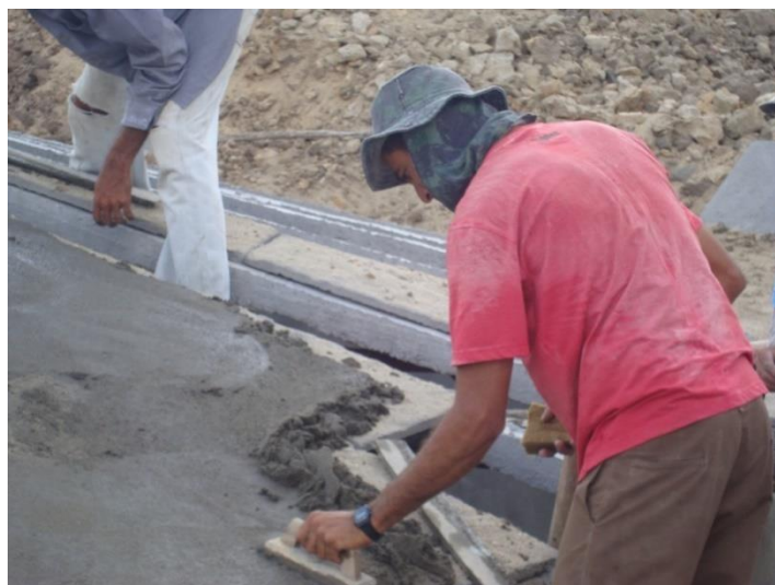
Figura 16: Colocação das Placas da Cobertura
