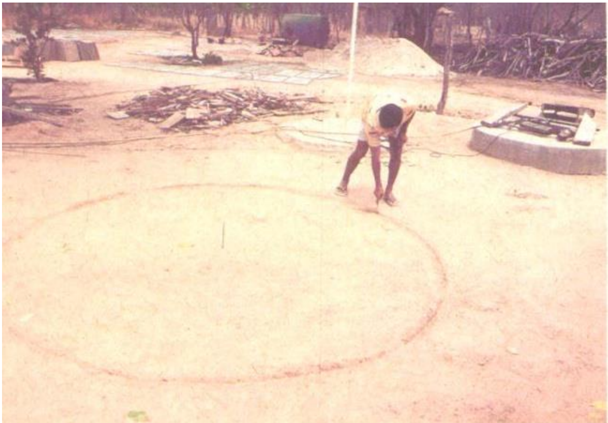
Figura 1: Marcação da área da cisterna
