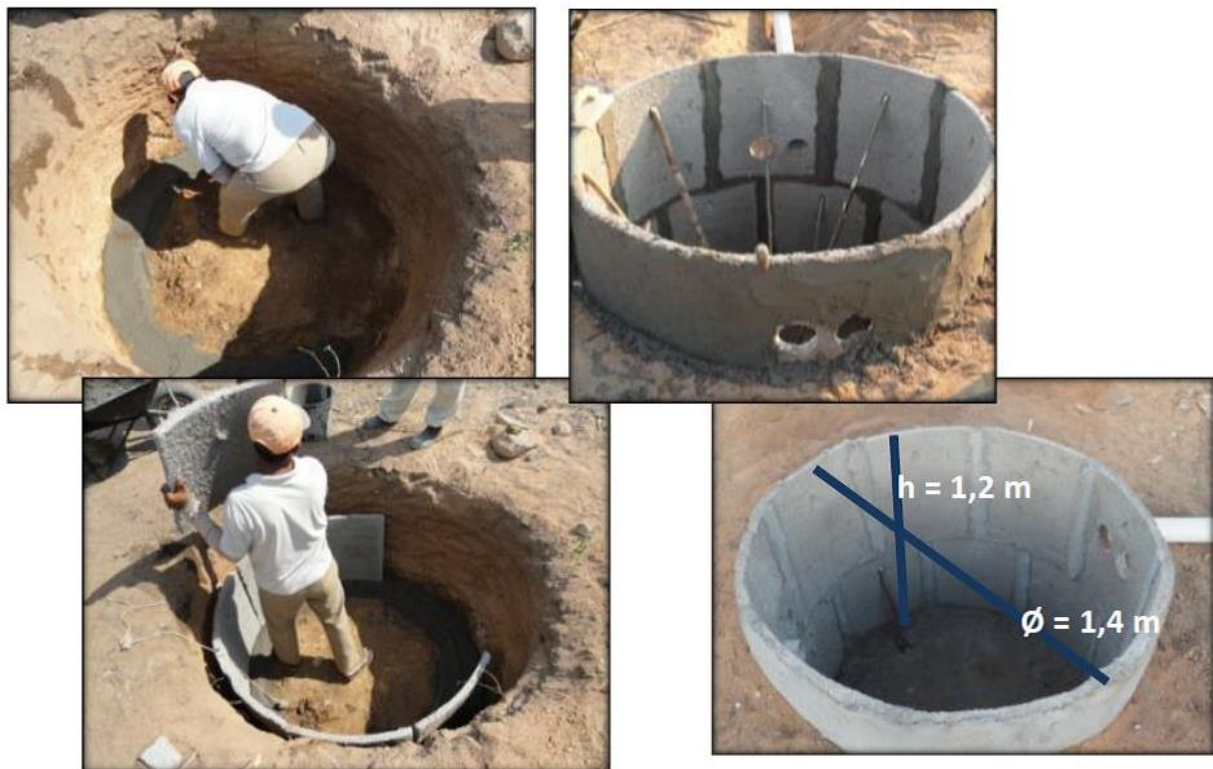
Figura 17: Construção dos decantadores
