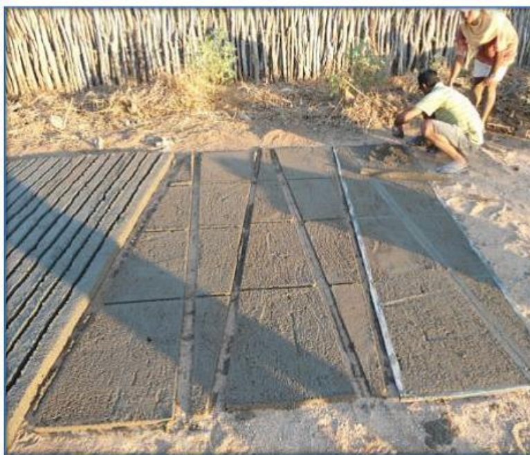
Figura 6: Fôrmas das 4 diferentes placas da cobertura da cisterna
