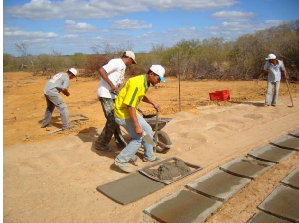
Figura 4: Medidas e confecção das placas da parede da cisterna
