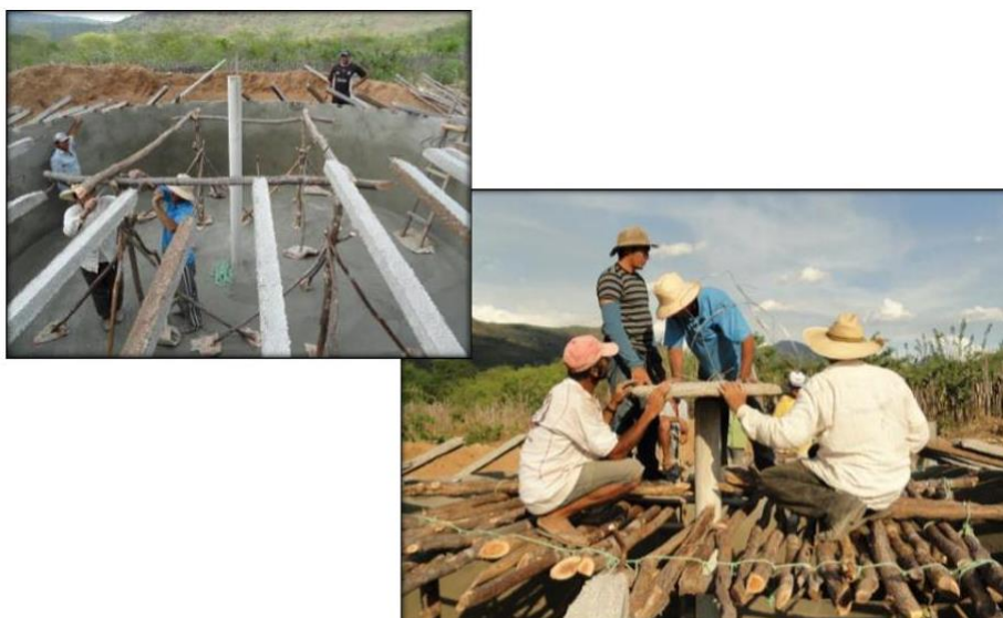
Figura 14: Colocação da Coroa
