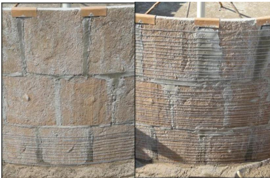
Figura 12: Amarração da parede da cisterna
