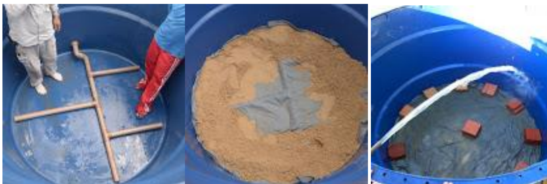
Figura 16: Exemplo de filtro lento de areia construído com caixa de 5.000 litros.
