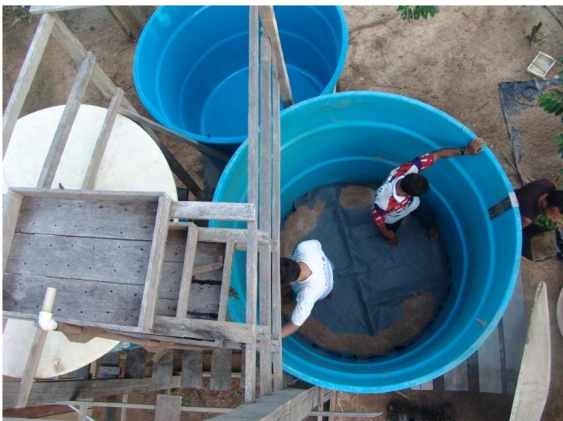
Figura 15: Exemplo de filtro lento de areia construído com caixa de 5.000 litros.
