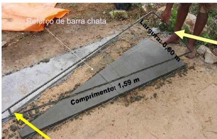
Figura 2: Modelo das placas da cobertura
