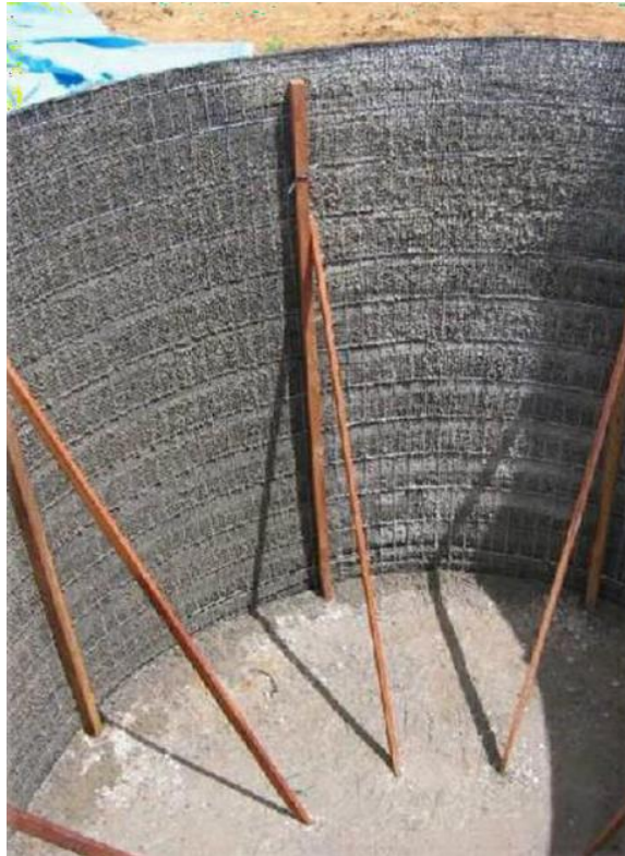
Figura 8: Ilustração das escoras da parede da cisterna
