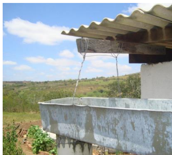
Figura 12: Sistema de captação de água de chuva
