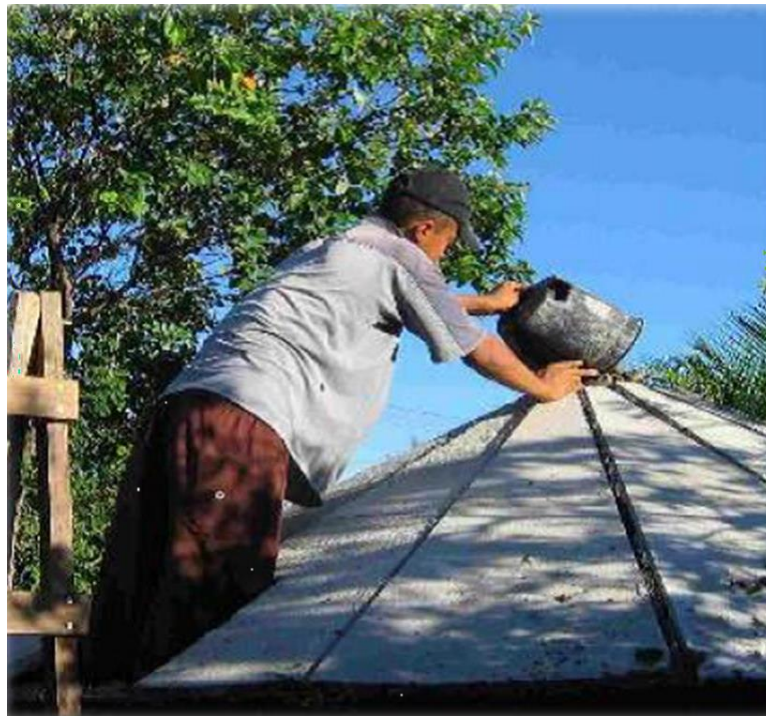
Figura 11: Confeção da cobertura da cisterna
