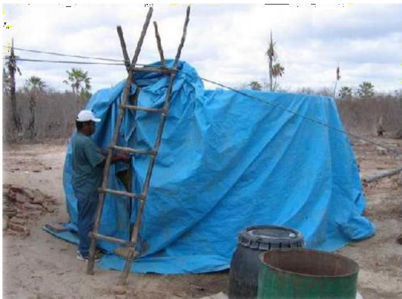
Figura 9: Cisterna coberta com lona plástica
