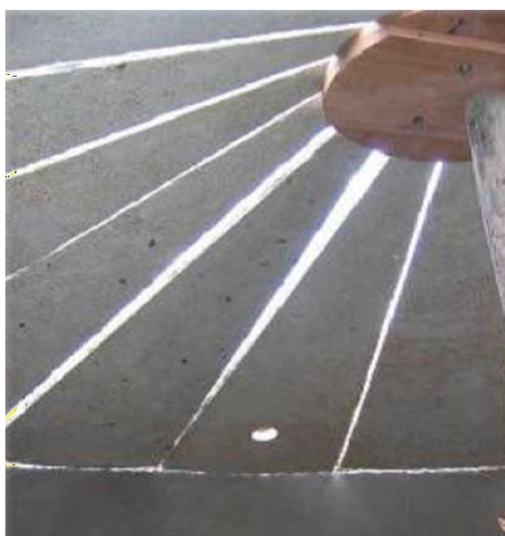
Figura 10: Confecção da cobertura da cisterna
