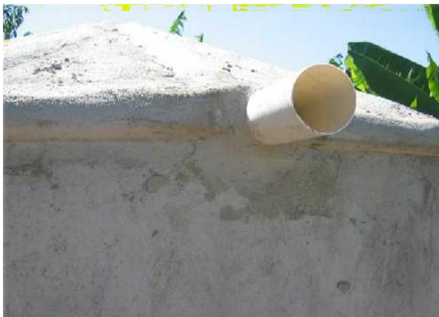
Figura 11: Instalação do vertedouro da cisterna
